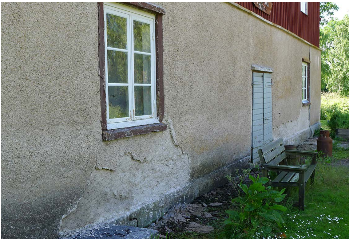
På fasaden mot vägen var inte skadorna lika stora, och en gradvis utstockning räckte för att nå rätt nivå. Juli 2012.
