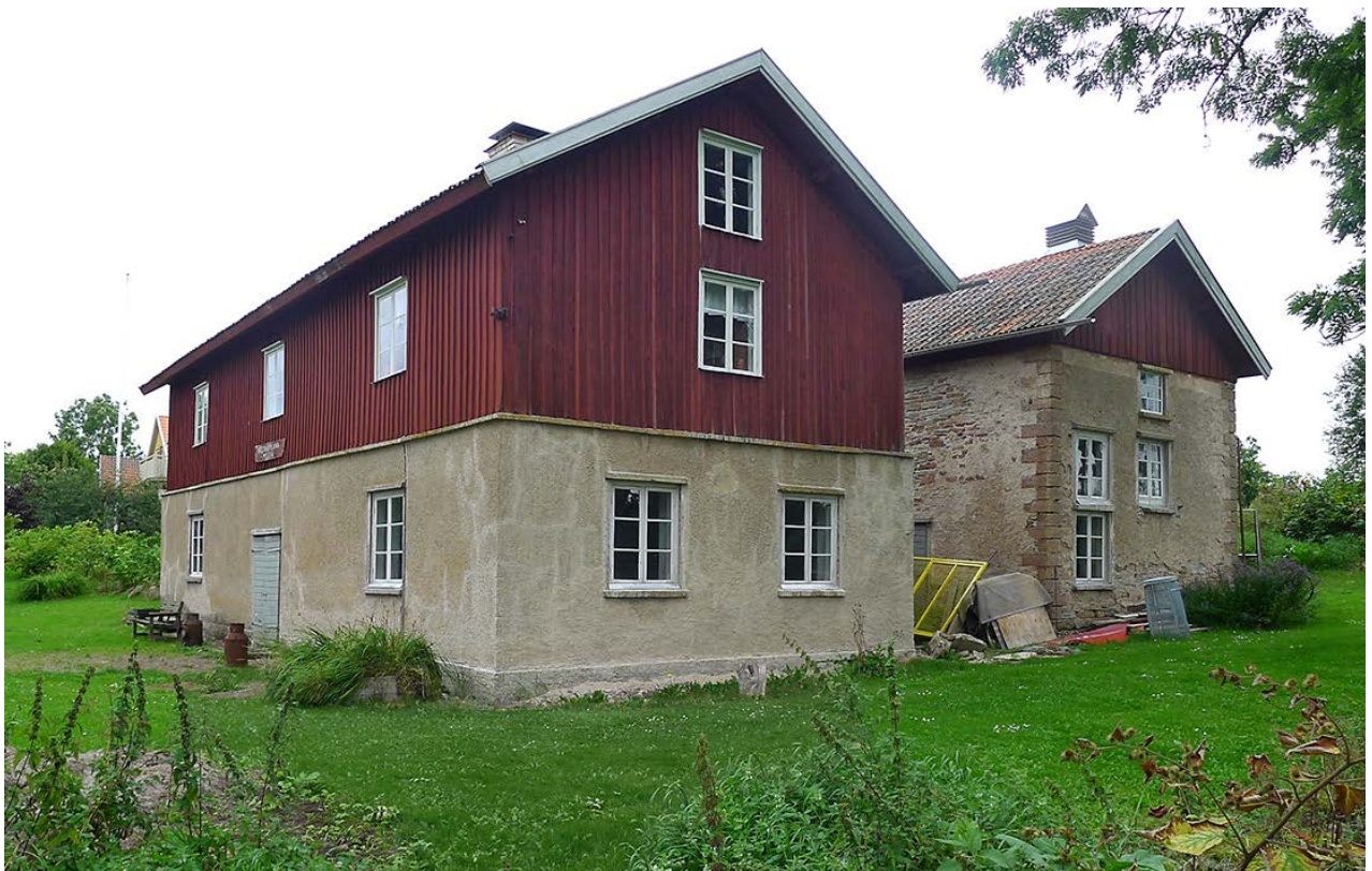
Tio år efter renoveringsarbetena började, har nu Västerplana mejeri blivit en prydnad för trakten, samtidigt som husen fortsätter att berätta om hur man i äldre tid har byggt av det lokala byggnadsmaterialen. Sept. 2012.
