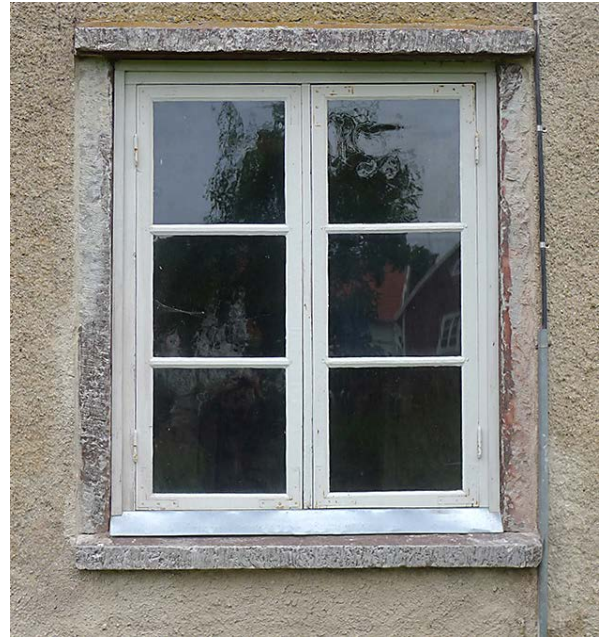
Den gamla putsen hade varit ganska slarvigt påslagen vid fönstren, med överskott på de välhuggna fönsteromfattningarna av kalksten. Dessa gjordes rena från putsrester och färg. Aug. resp. sept. 2012.
