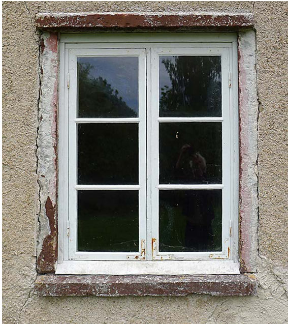
Den gamla putsen hade varit ganska slarvigt påslagen vid fönstren, med överskott på de välhuggna fönsteromfattningarna av kalksten. Dessa gjordes rena från putsrester och färg. Aug. resp. sept. 2012.
